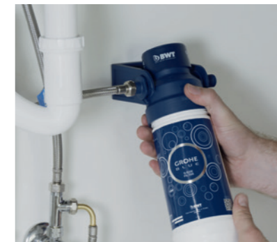
Bevestig de filterhouder op de kast en schroef het filter in de filterkop. Sluit vervolgens het filter aan op de koudwatervoorziening.
